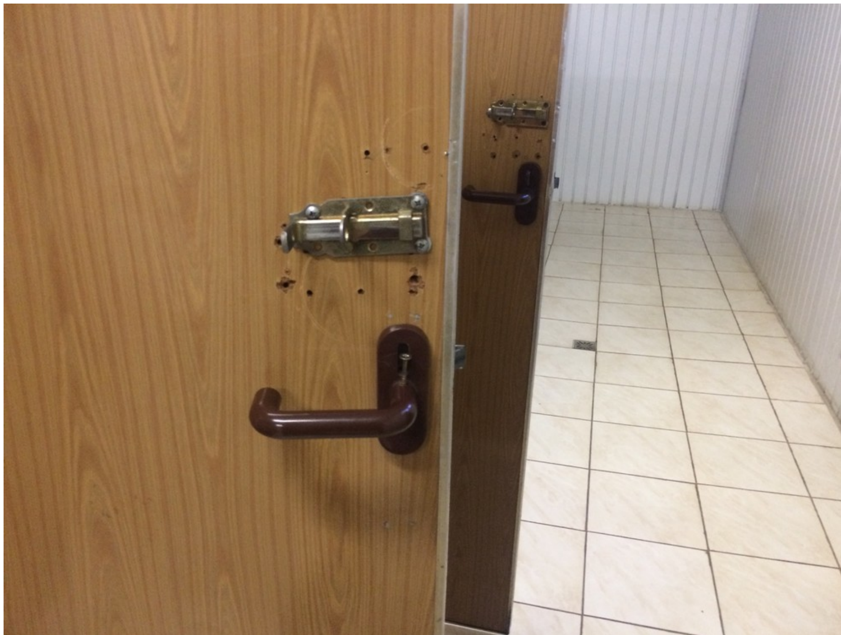
“Nové” dvere WC po EYOFe – drevotrieska sa rozpadá.
